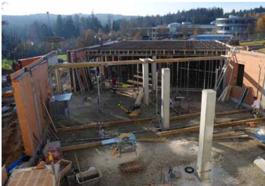
Jeden Tag ein Stück mehr: Die Gebäudeerweiterung Richtung Westen nimmt langsam Formen an.
